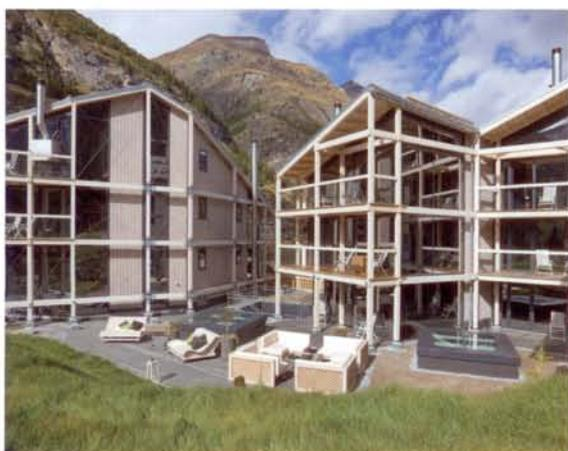
Die Fassaden der Neubauten bestehen aus Holz und grossflächigen Verglasungen, in denen sich die umgebende Bergwelt widerspiegelt. Eingesetzt wurden ca. 700 m<sup>2</sup> des Sonnenschutzisoliervlas TG-THERM**SUN**, bestehend aus TG-ESG und TG-PROTECT. Eingefasst werden die Fassaden von einem Holzgerüst, das den einzelnen Gebäuden skulpturale Formen gibt. Die Dächer sind traditionell aus Stein.
